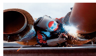
Obr:1-6: Oblúkové ručné zváranie.
